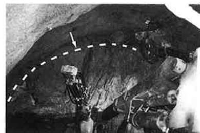
穿孔位置マーキング 作業状況
