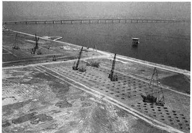
関西空港における当工法の施工機械群
