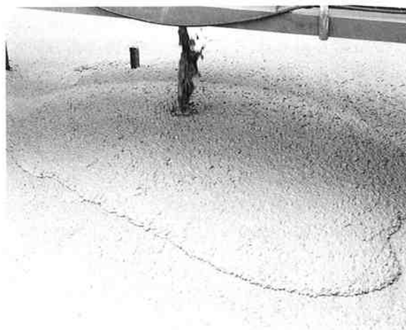
高流動コンクリート施工状況
