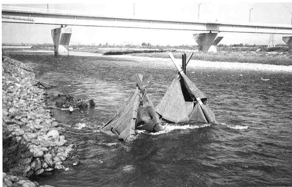
水防新工法「鋼製川倉」
