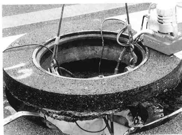
吊上げ撤去状況
