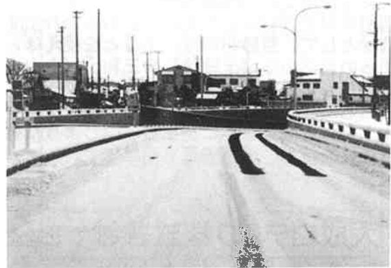
北海道 苫小牧市立体交差 市道旭大通
