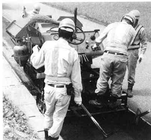
スーパーミニフィニッシャの施工状況
