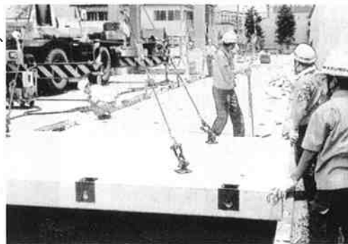
継手と快結プレートの配置
