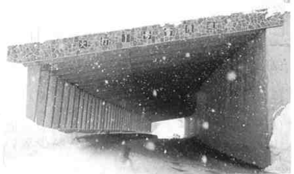
新潟県 国道17号線 火打1号スノーシェッド工事
