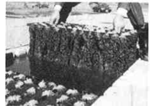
バイオモール汚泥附着状況
