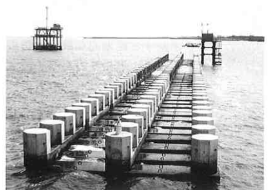
駿河海岸離岸堤
