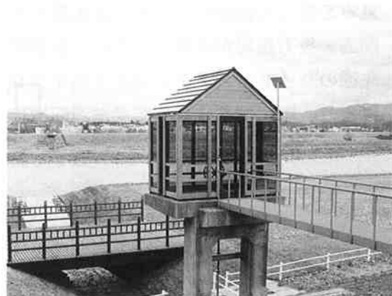
樋門管理に役立つ樋門ハウス
