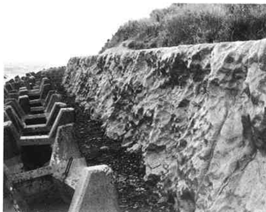
エプロックによる造景岩擁壁（現場打設法）
