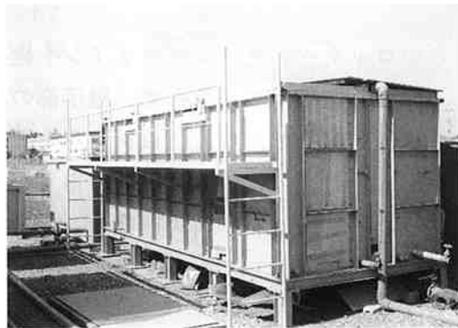
河川浄化実験施設
