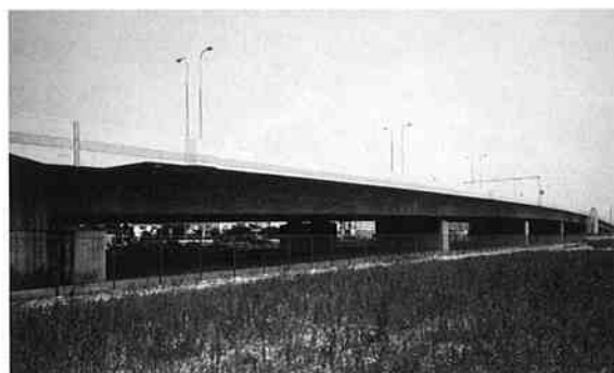
免震橋（東扇島高架橋）
