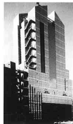
制震ビル (メディアシティ静岡)
