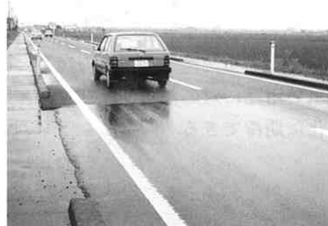
雨天時の薄層排水性舗装
