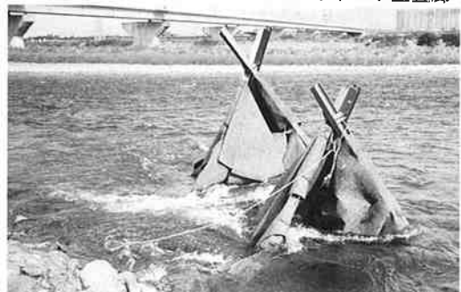
水防新工法(鋼製川倉)
