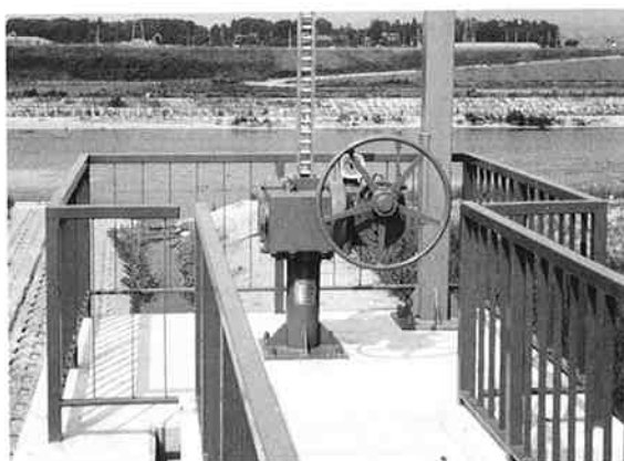
ネオラックが設置された樋門全景
