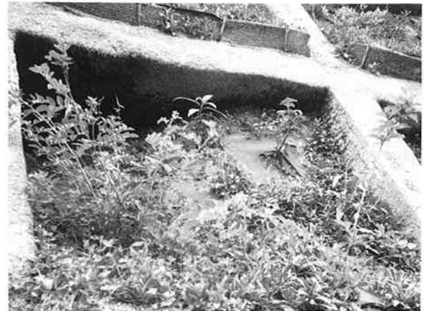
切土法面乾燥立地緑化工法
