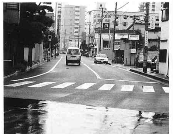
雨天時の薄層排水性舗装
