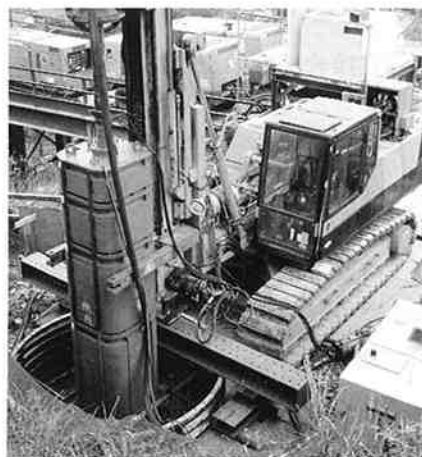
硬岩対応型・深礎機械化工法
