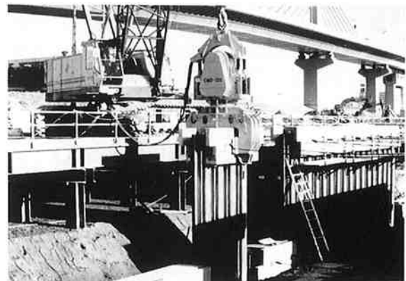
没水型低水護岸急速省力化工法
