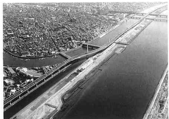
法面保護ネットを使用した多自然型護岸
