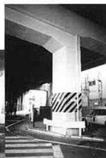
アラミド繊維RC橋脚補強工法
