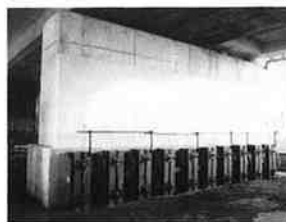
壁式橋脚耐震補強工法
