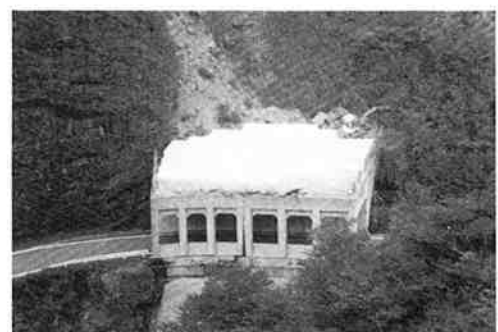
特殊発泡スチロール設置状況
