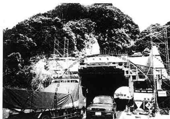
丑山トンネル
