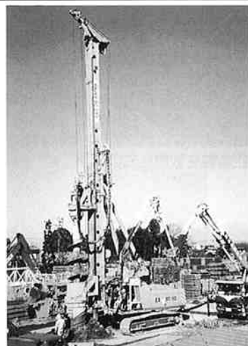
【掘削機 (掘削・引き上げ・置換)】
