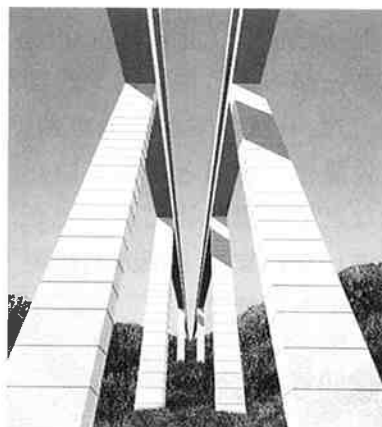
高橋脚建設技術「3H工法」
