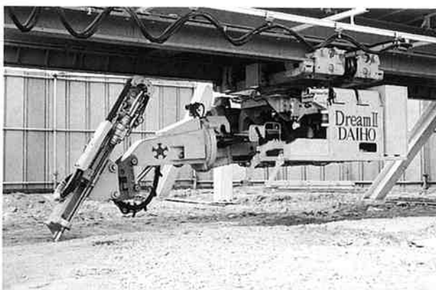
多機能型ケーソン掘削機 DREAM II
