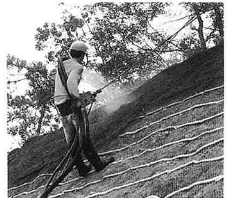
植生基盤材吹付作業
