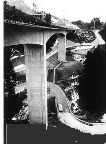
ソヨギ第二橋橋脚（岐阜県）
