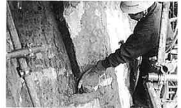
目地工（上）、注入工（下）
