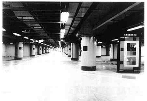
地下駐車場現場
