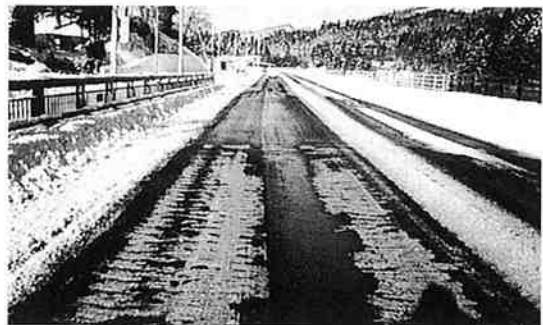
凍結抑制効果の状況 作並道路 (宮城県)
