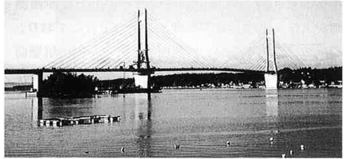
中能登農道橋全景（左側がP2側）
