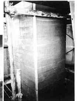
アラミドシート 巻き立て補強工法
