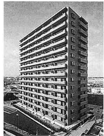
パラッショ青葉(免震建物)
