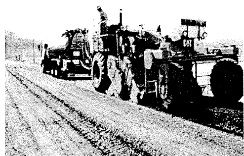
SKS 工法施工状況
