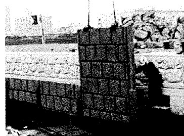
ウェットコンクリートでカニが好む石積機能を再現した「カニ護岸パネル」
