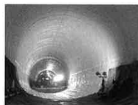
ハイイータス工法で施工したシートの状況
