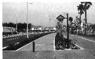
歩道での 施工例
