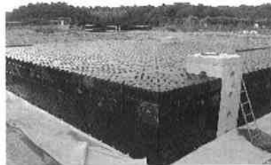
プラスチック製 貯留槽 (アクアトラップ) の設置状況
