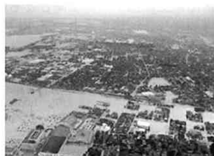
五十嵐川破堤による三条市浸水状況
